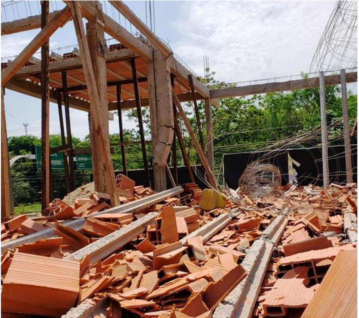
Así quedó la estructura de la planta alta de edificio luego de desplomarse.
