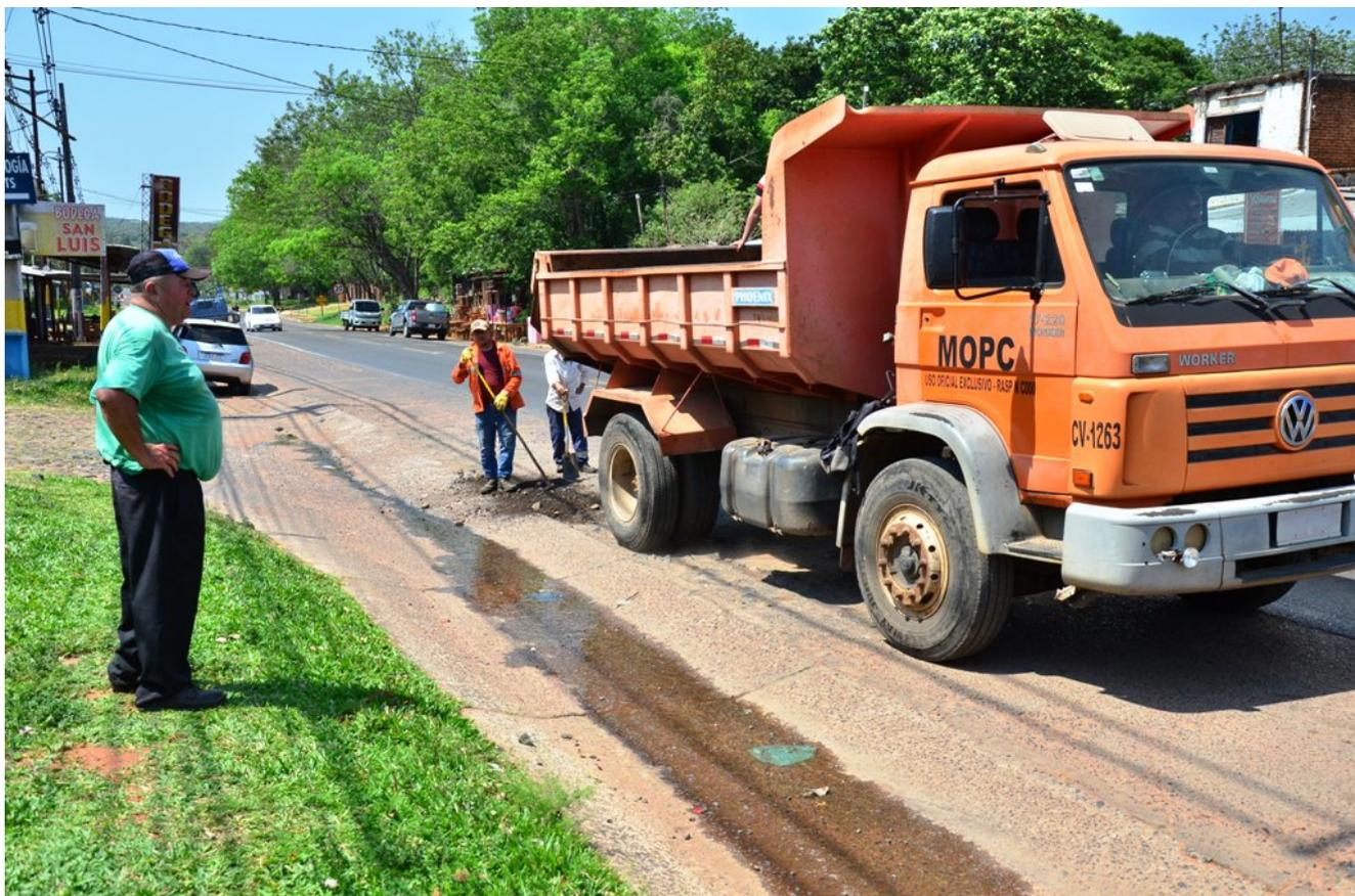
Obreros del MOPC realizaron el desastroso bacheo, empleado el fresado de asfalto en la ruta Luque-Areguá.
