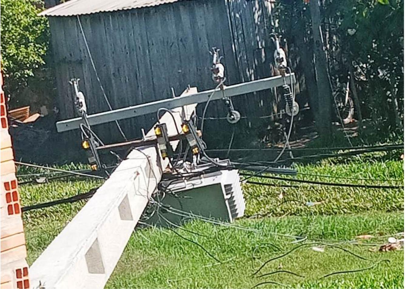
El fuerte viento derribó esta columna de hormigón con el transformador y sigue con energía eléctrica, según la denuncia de los pobladores del asentamiento San Pedro, de Mora Cué, Luque.
