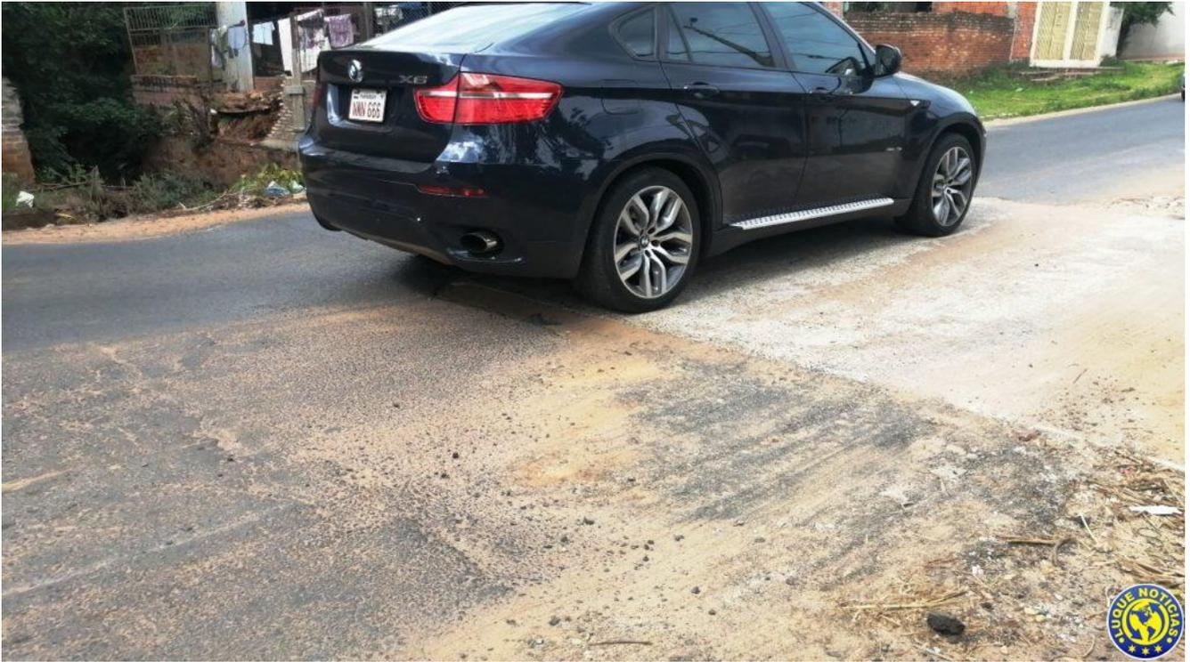
Pronunciado desnivel entre el asfaltado y el puente reparado que produce un fuerte golpe a los vehículos que pasan por el lugar.
