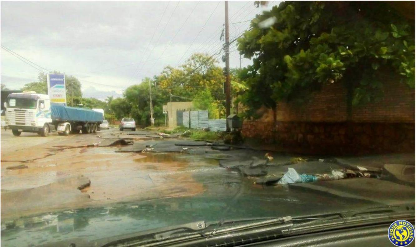
El raudal se llevó casi todo el asfaltado. La fuerte correntada levantó por bloque la capa asfáltica.
