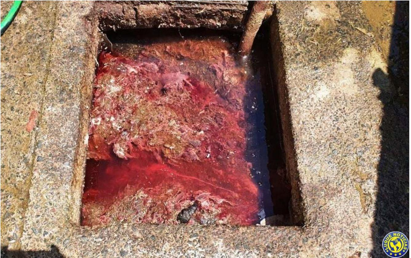
Según manifestaciones del encargado, hubo una rotura de una de las cañerías de PVC que proviene del sistema de decantación que conecta a una pileta de planta de tratamiento, lo que fue el causante de la filtración de los efluentes a la naciente, según el mismo ese desperfecto fue subsanado. Los interventores también informaron sobre la colmatación de las rejillas y canales de desagüe con restos de pelambre.
